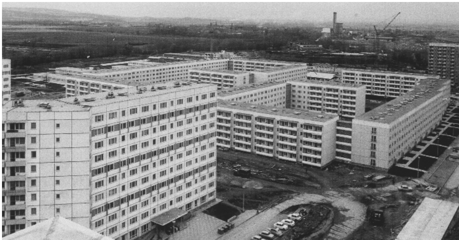
Erfurt: Lowetscher Straße, 1975 (Foto: Stadtarchiv Erfurt)
